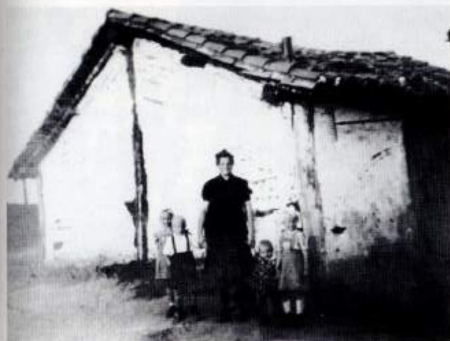
Casa destinada aos Sanders, em Holambra, em 1949.
